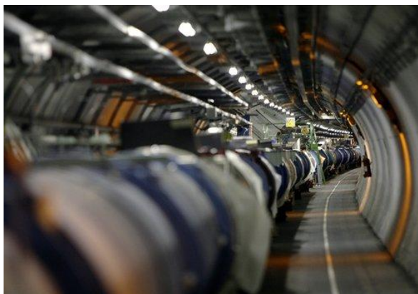
Tunel urychlovače LHC
